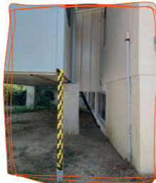
Passerelle entre cuisine et préfabriqué vue extérieure
