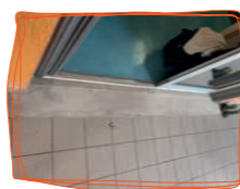
Réfection des sols couloir maternelle
