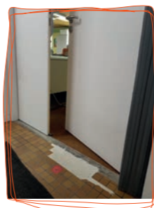
Réfection des sols entrée de classe
