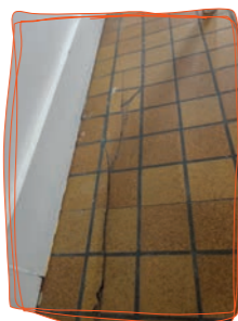
Sols avant réfection
