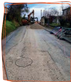
Raccordement aval réalisé
