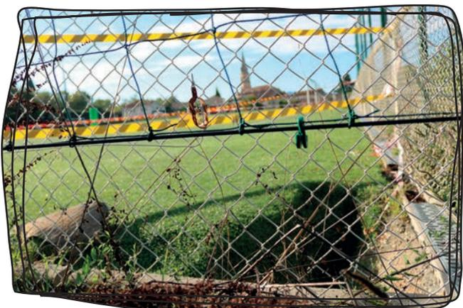
Le talus du terrain synthétique, angle au fond à gauche est lourdement affaissé et le coin du terrain commence également à s'affaisser. Si le budget de cette fin d'année nous le permet, nous lancerons un appel d'offre pour la réalisation d'un enrochement afin de tenir le talus et sauver notre terrain, qui sert pour plusieurs équipes de sports.
