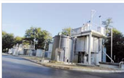
La station d'épuration
